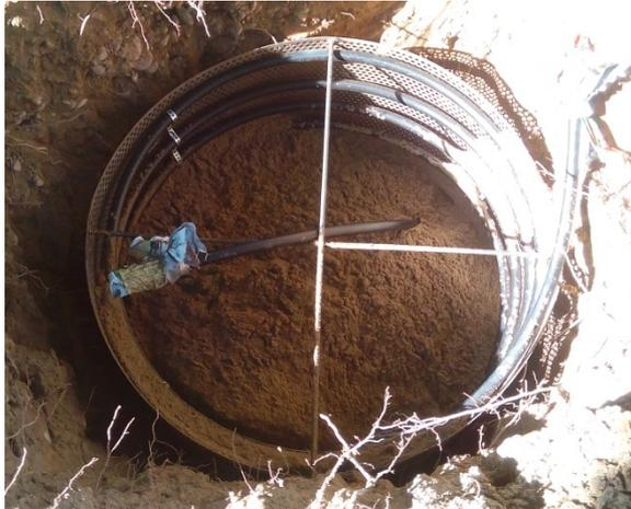
**GEOBOND** la sonda geotermica compatta studiata e realizzata per massimizzare il funzionamento e le prestazioni delle pompe di calore elio-assistite. Con poco spazio di terreno e poco costo si riesce ad integrare l'energia mancante dal solare ibrido e funzionare come batteria termica quando l'energia è in eccesso.
